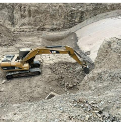
**VERTEDERO.** Son estructuras de control hidráulico. Su función es la de presentar un obstáculo al libre flujo del agua, con el consiguiente represamiento aguas arriba de la estructura, y el aumento de la velocidad aguas abajo. Estructura que permite evacuar los volúmenes del agua embalsada que superen un nivel generalmente unos tres o cuatro metros por debajo del coronamiento de la presa. Los hay de cresta libre seguido de un rápido y una estructura disipadora, o también de borde libre.
