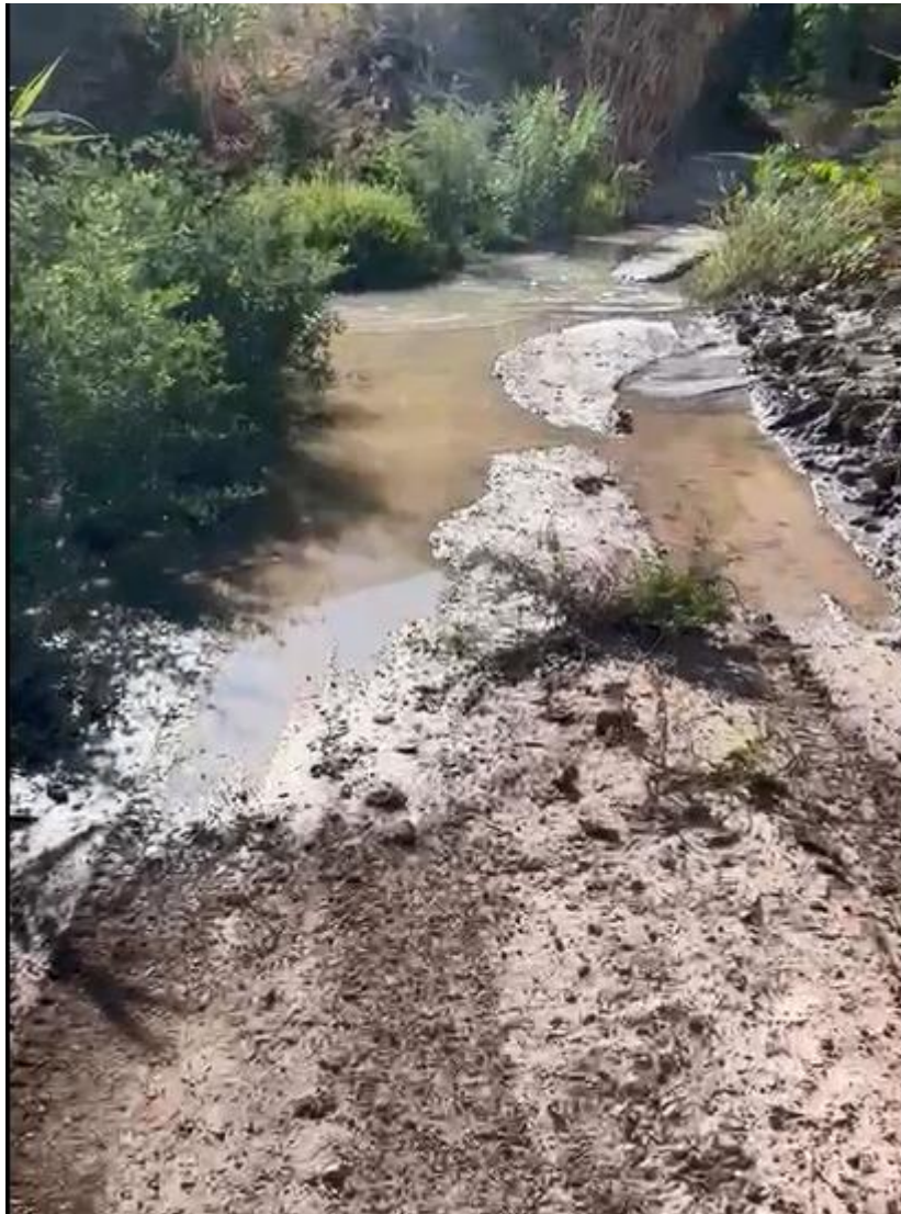
Imagen: filtración del muro Canal La Turbina
