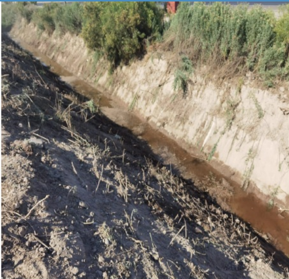
Estado del canal despues de la limpieza
