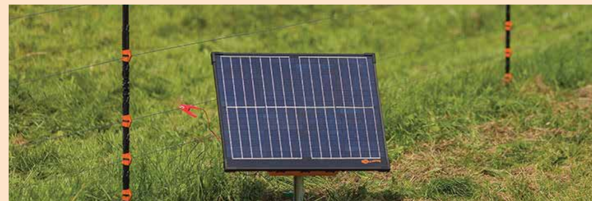
Figura 75. En las comunas de Mulchén, Negrete y Nacimiento lograron fondos para instalar cercos eléctricos que evitan el ingreso de animales a canales de riego.
