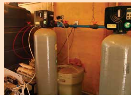
Figura 93. Planta de tratamiento con uso de filtros y equipo de osmosis inversa, que cuenta con un estanque plástico de cinco mil litros para acumular el agua tratada.
