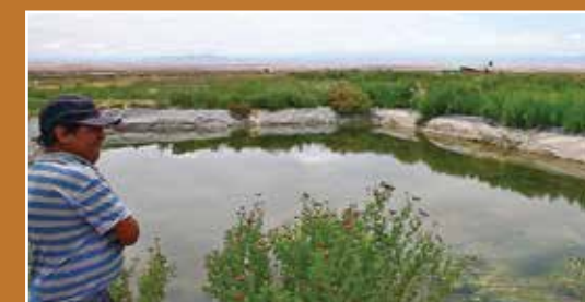
Figura 2. Estanque revestido con geomembrana de 120.000 litros de capacidad.
