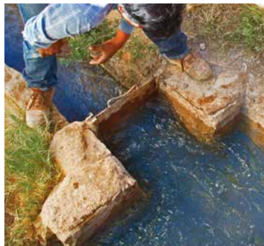
Figura 3. Para el ingreso del agua desde el canal al cultivo en la terraza se utiliza una compuerta.
