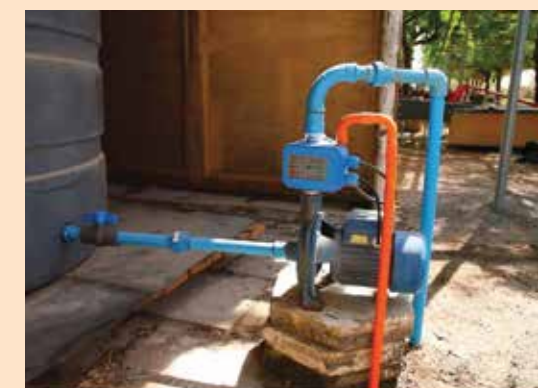
Figura 94. El agua tratada se acumula en el estanque y desde ahí es impulsada por un equipo de bombeo para el riego en el sector de cultivos.
